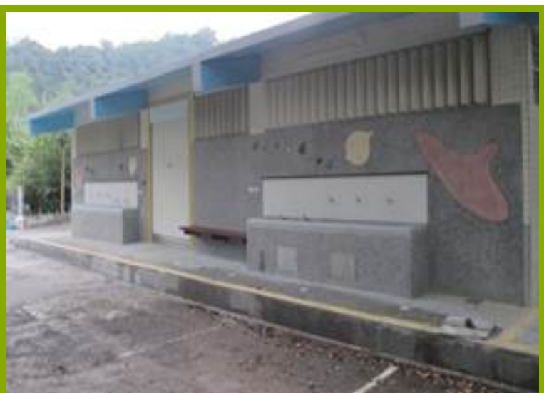
圖1：更衣淋浴間設施
