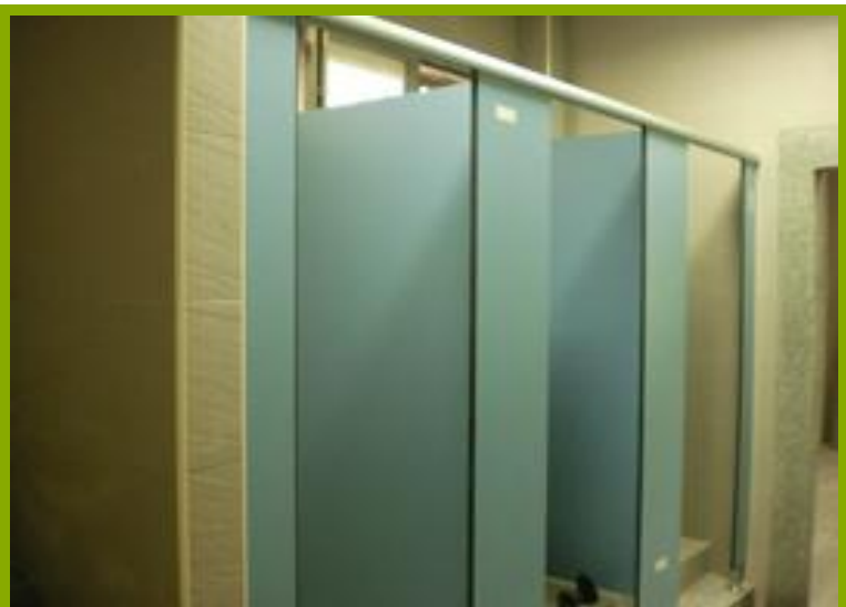
圖1：更衣淋浴間設施
