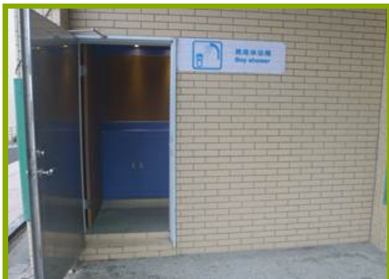
圖1：更衣淋浴間設施
