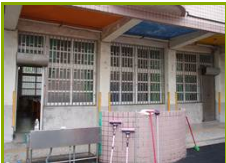
圖1：更衣淋浴間設施
